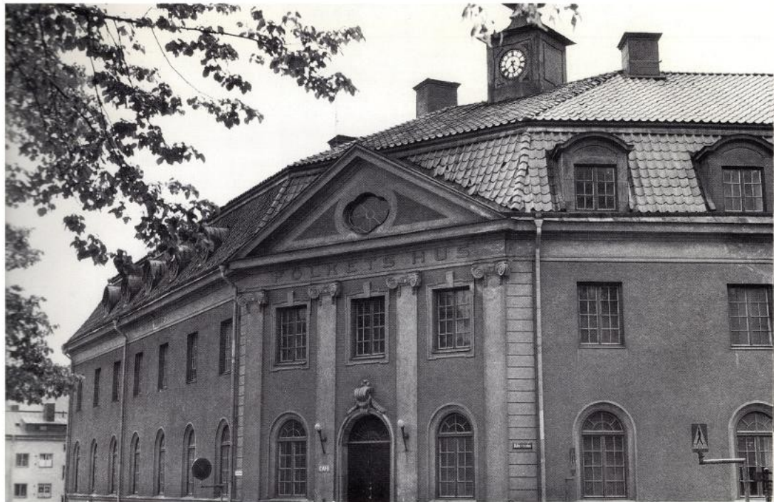
Gamla Folkets Hus på Oxbacken stod klart i slutet av 1923 och användes flitigt till dess att Nya Folkets Hus invigdes hösten 1970. Sommaren 1971 revs den gamla byggnaden, här sedd från sydost.
